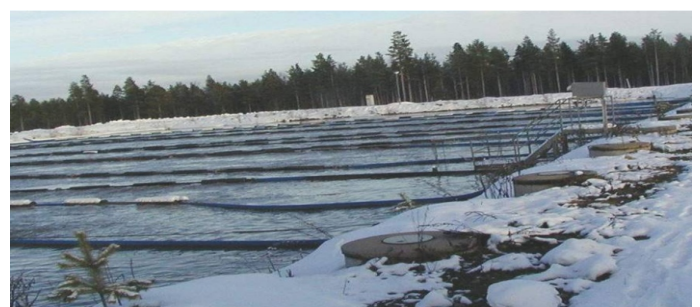
Kommunale Anlage in Polen, 4.200 EW 60
