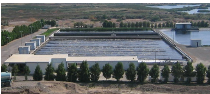
Kommunale Anlage in Saudi Arabien, 100.000 EW 60
