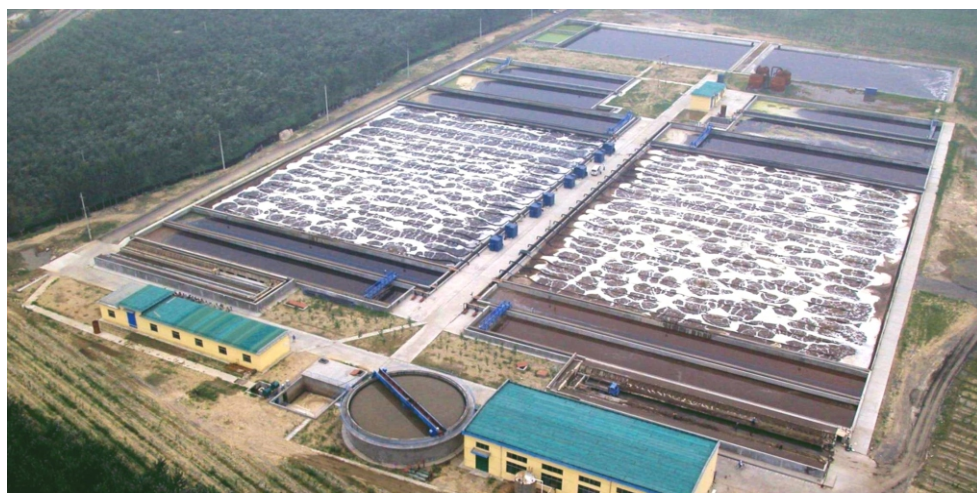
Anlage für einen Zellstoffindustriebetrieb, 60.000 m 3 /d - 1.300.000 EW 60
