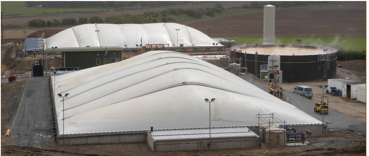
BIOLAK ® GAS Liquid-Anlage für eine Brennerei ca. 61 t CSB/d and 1.600 m 3 /d
